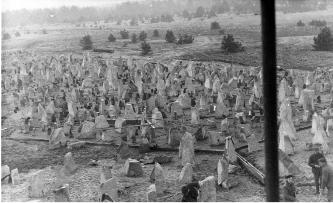
Kolejne stadia robót sfotografowane w 1963 roku prawdopodobnie przez Adama Haupta. Na drugim planie widać gotową betonową płytę. Na pierwszym planie beton zostanie dopiero wylany (fotografia z archiwum Adama Haupta, cyt. za: Radecka, 2011)
